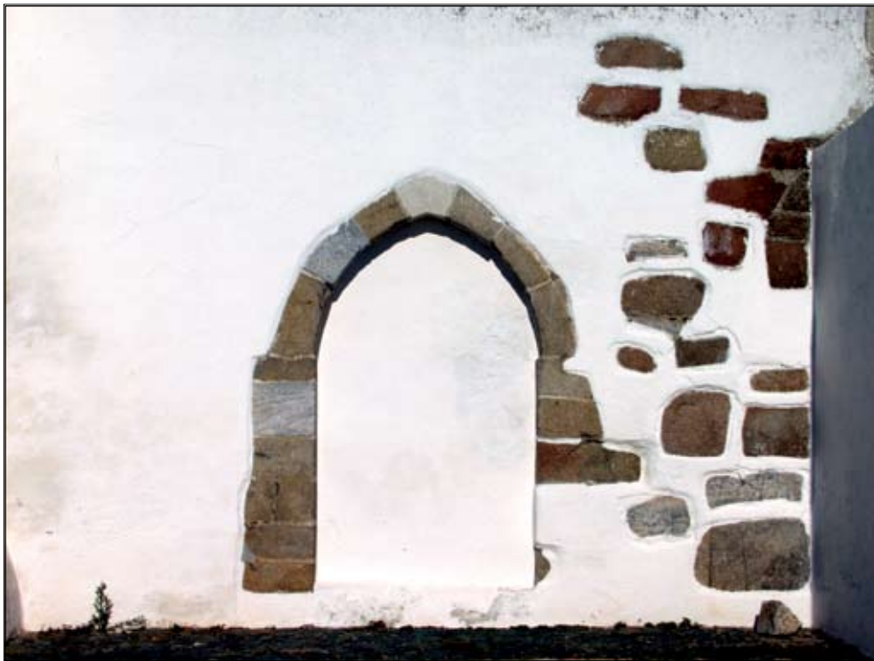
▲ Alçado Sudeste. Portal remanescente da obra hospitalária medieval. [VV]
