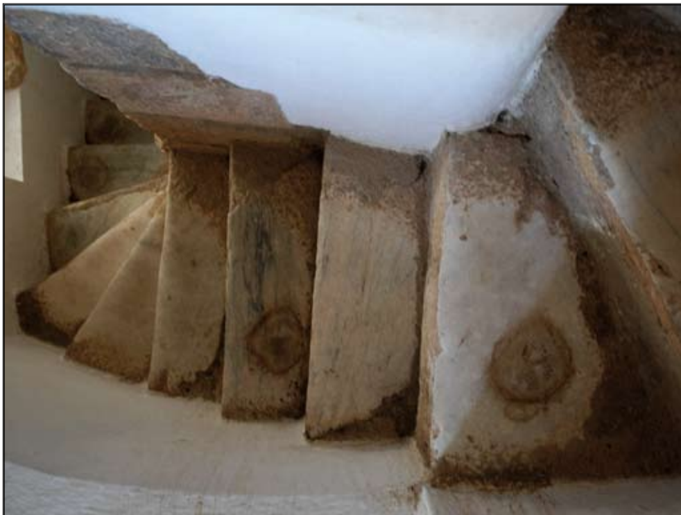
▲ Torre sineira, interior. Pormenor do lance da escadaria [VV]
